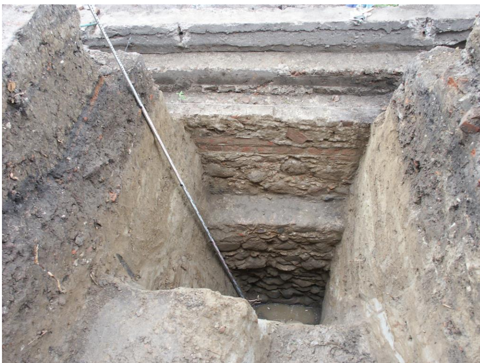
Ilustracja 6. Olsztyn wykop 50 b. Widok ogólny wykopu wraz z fundamentem wewnętrznym tzw. muru niskiego (od strony międzymurza). Widoczny jest bardzo solidny fundament muru obronnego wraz z szeroką odsadzką fundamentową. Fot. A. Mackiewicz.
