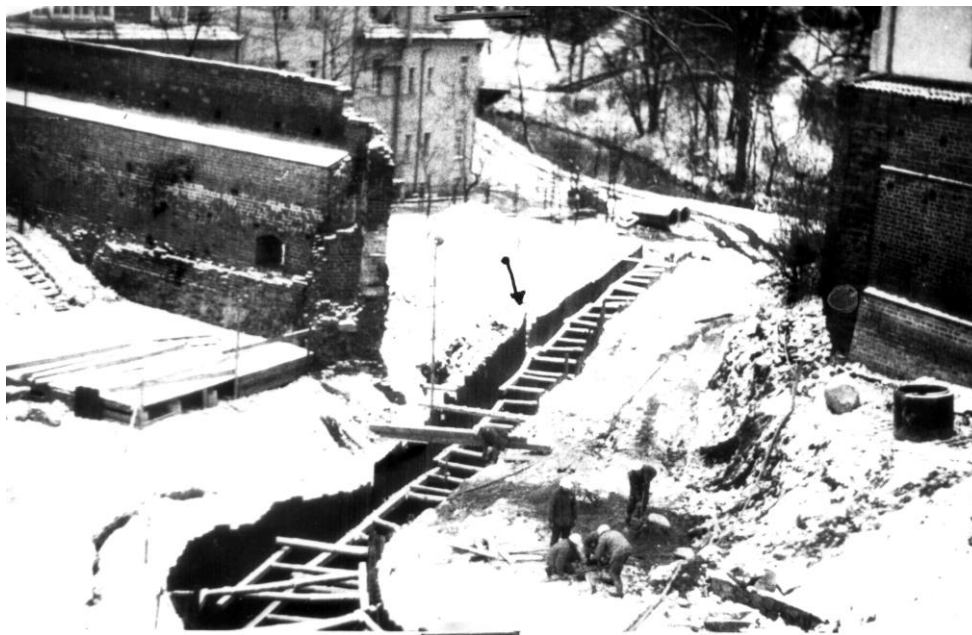
Ilustracja 1. Widok ogólny wykopu pod kolektor "C" od strony wschodniej. Fot. 1.2 z dokumentacji "Ekspertyza w zakresie stanu technicznego budynku WSS-E w Olsztynie". Autor zdjęcia nie podany. 35
